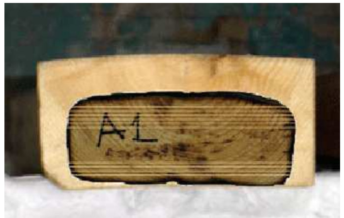
Figura 32.19. Comparación de un elemento de madera antes y después de ser afectado por el fuego, apreciándose la pérdida de sección.
