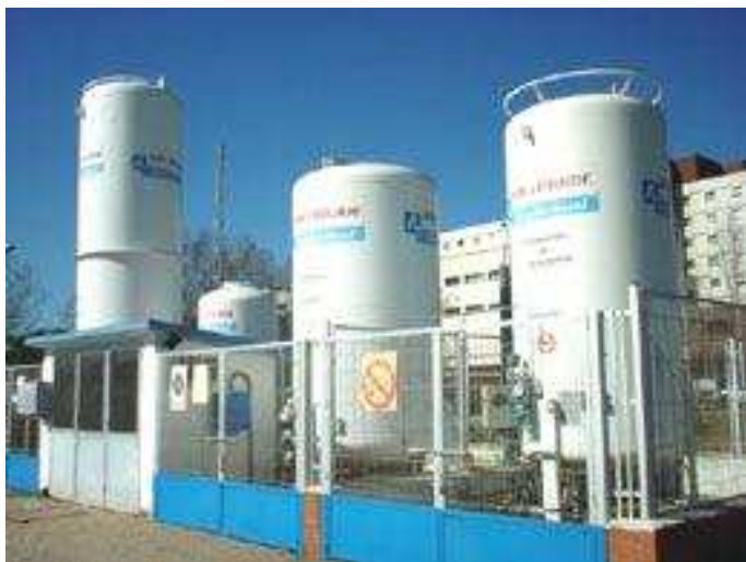
Figura 25.6. Instalaciones de gases medicinales de un hospital
