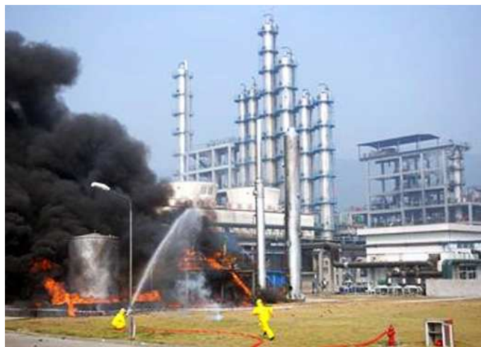
Figura 25.1. Los incidentes con productos químicos pueden implicar riesgos muy elevados para las personas o el medio ambiente.
