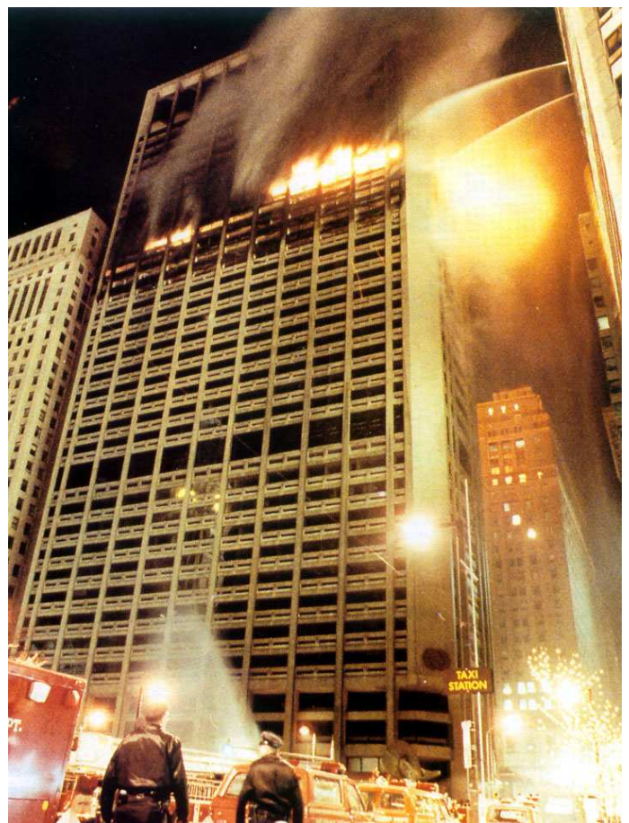
Figura 13.20. Los incendios en edificios altos plantean retos especiales para la lucha contra el fuego.
